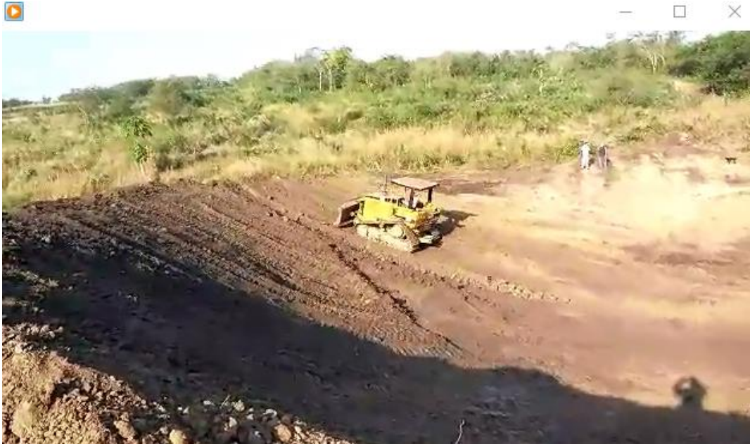
Foto No 3: Trabajos en reservorio No 2 Vereda Santa fé.
